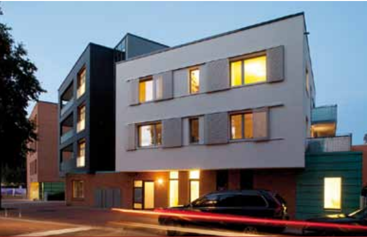
Frontpage: Torhaus Gilde-Carré, Hannover, Gerd Nord, Lindener Baukontor © Frank Ausstieker
